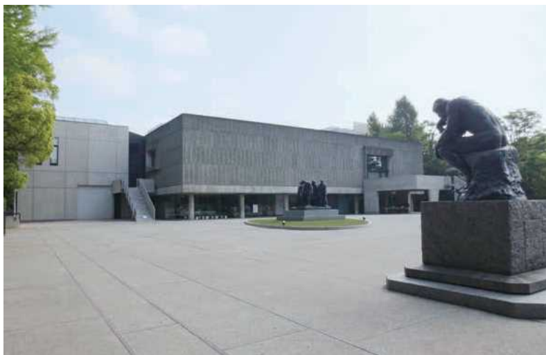
前庭の改装工事をするなどリニューアル後の国立西洋美術館
