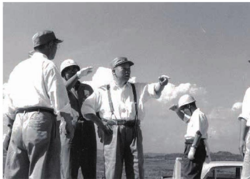
水島製鉄所建設現場で指揮をとる西山弥太郎=1962年9月
