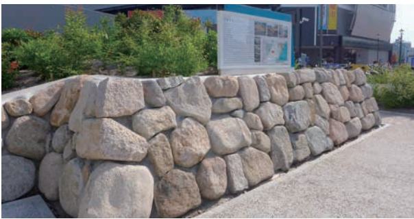
発掘調査で見つかった石を使い、再現された兵庫城の石垣のイメージ
