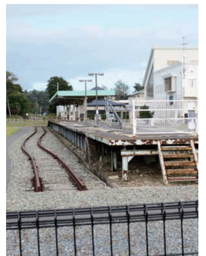
地震や津波で線路が曲がった旧野蒜駅プラットホーム
