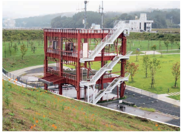
津波の恐ろしさを物語る防災対策庁舎
